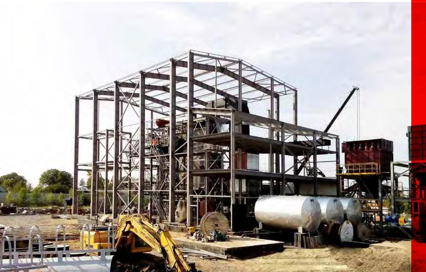
**Размеры:** котельная 33x18,5x18 м (высота в коньке – 21 м), склад топлива 15x23x8 м
