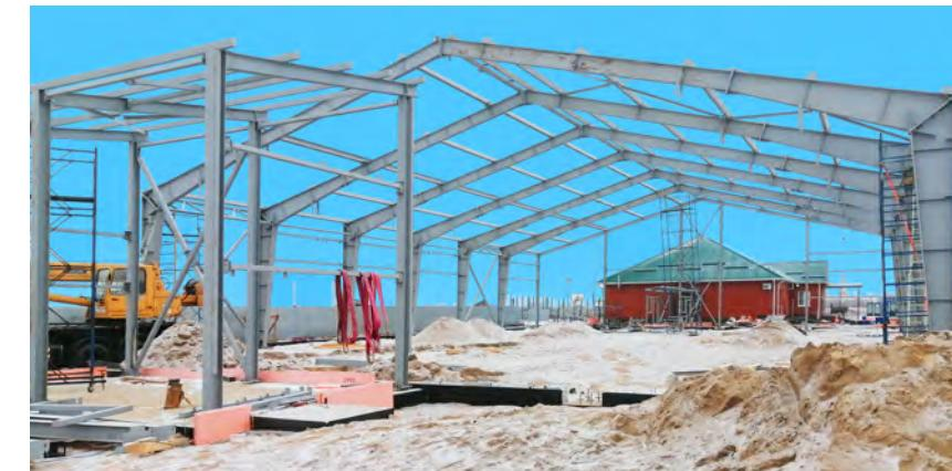
**Размеры:** спортивный зал - 44x27x5,7 м (высота в коньке 10,5 м); теплый переход - 8,1x3x3,4 м; вент-камера - 5,12x8,24x5,2 м
